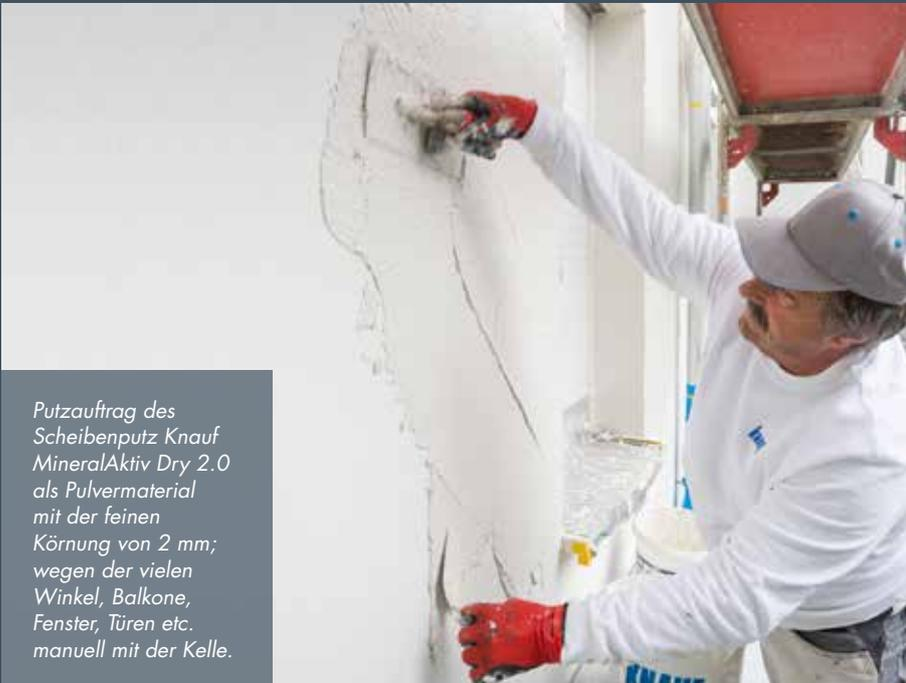
Putzauftrag des Scheibenputz Knauf MineralAktiv Dry 2.0 als Pulvermaterial mit der feinen Körnung von 2 mm; wegen der vielen Winkel, Balkone, Fenster, Türen etc. manuell mit der Kelle.
