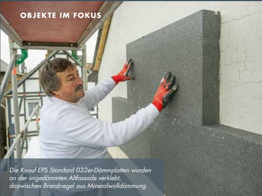
Die Knauf EPS Standard 032er-Dämmplatten wurden an der ungedämmten Altfassade verklebt, dazwischen Brandriegel aus Mineralwolldämmung.
