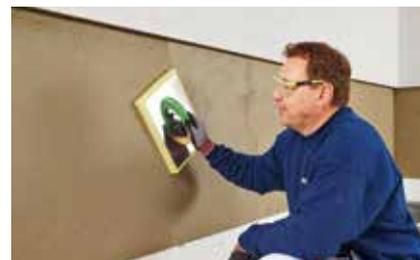
*Einer für alles: Bei einer Auftragsdicke von ≥ 7 mm benötigt der faserverstärkte Knauf Sockel-SM Pro keinen zusätzlichen Schutz vor Bodenfeuchte.*
