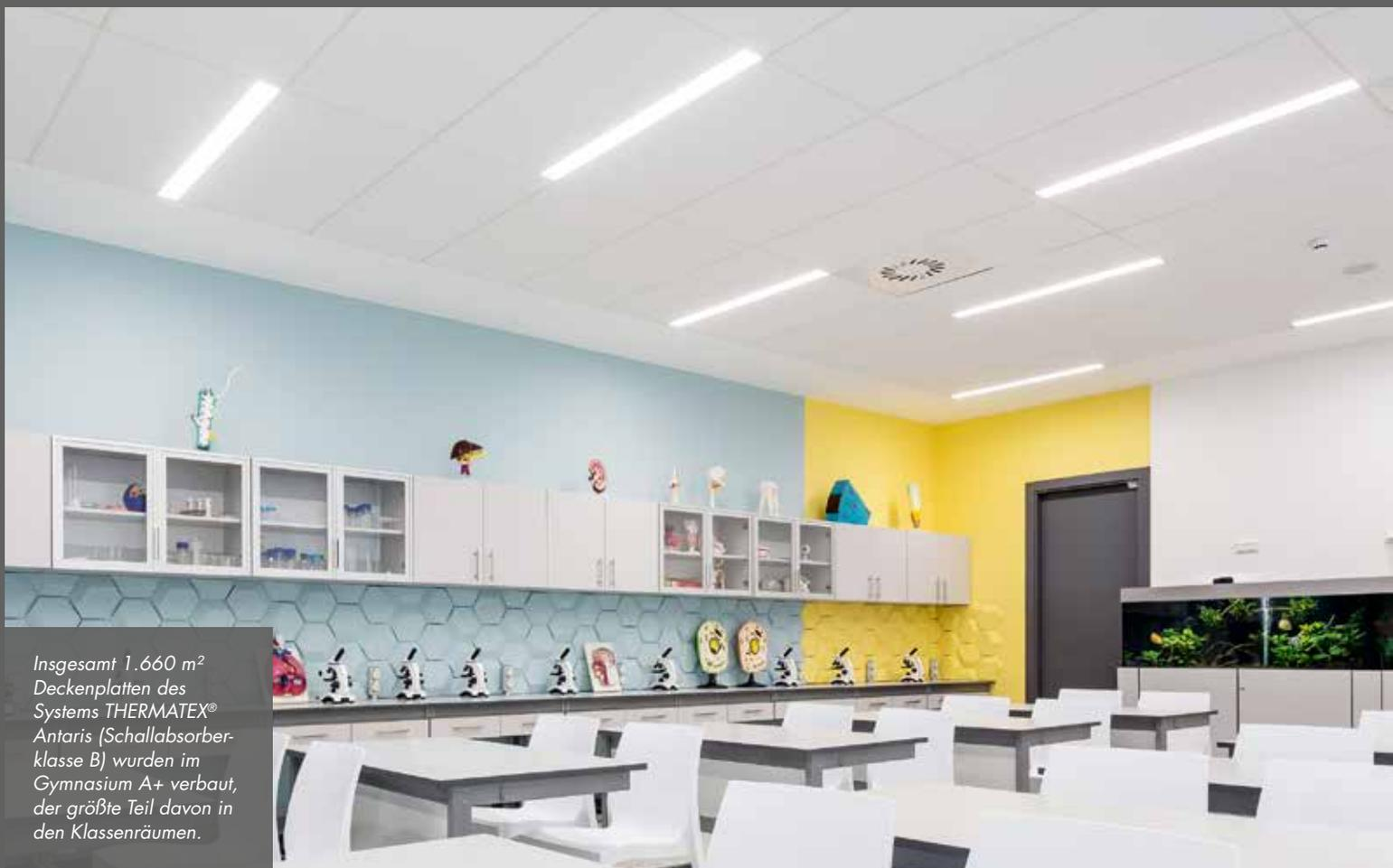
Insgesamt 1.660 m<sup>2</sup> Deckenplatten des Systems THERMATEX® Antaris (Schallabsorberklasse B) wurden im Gymnasium A+ verbaut, der größte Teil davon in den Klassenräumen.
