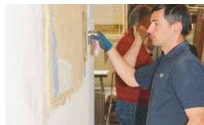
*Knauf Gigamit ist in einem Arbeitsgang Haftbrücke, Unterputz und Armierungsmörtel für Mauerwerk.*
