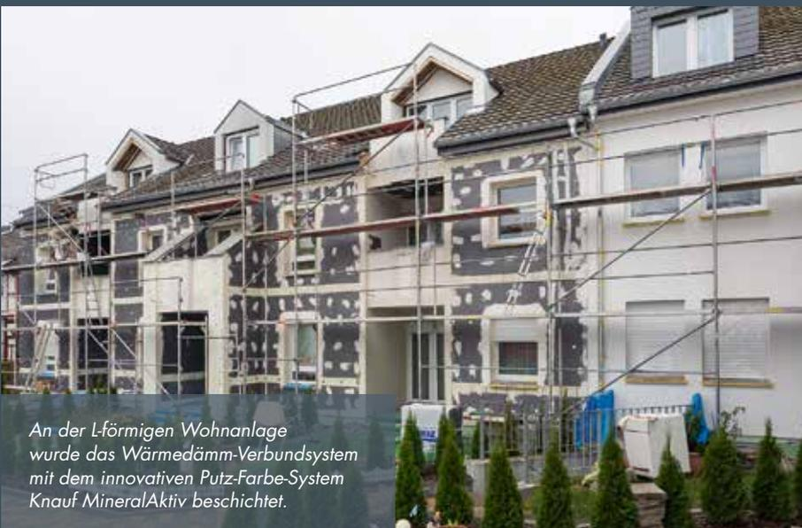
An der L-förmigen Wohnanlage wurde das Wärmedämm-Verbundsystem mit dem innovativen Putz-Farbe-System Knauf MineralAktiv beschichtet.
