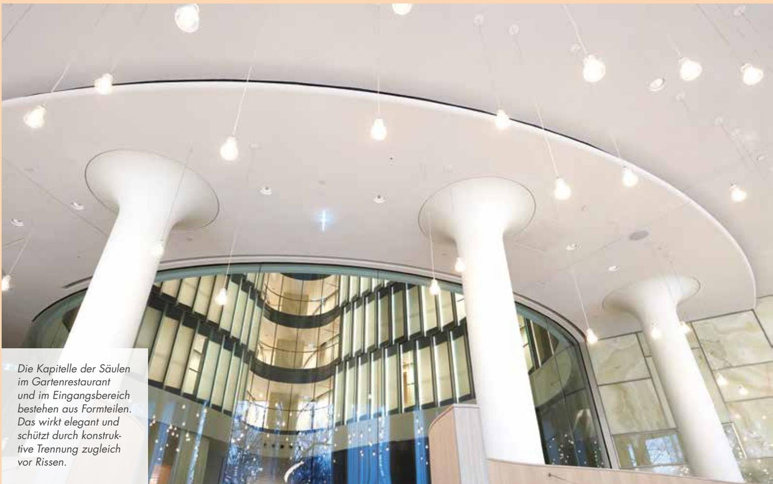
Die Kapitelle der Säulen im Gartenrestaurant und im Eingangsbereich bestehen aus Formteilen. Das wirkt elegant und schützt durch konstruktive Trennung zugleich vor Rissen.
