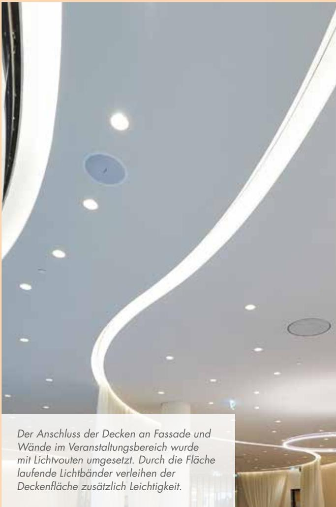
Der Anschluss der Decken an Fassade und Wände im Veranstaltungsbereich wurde mit Lichtvouten umgesetzt. Durch die Fläche laufende Lichtbänder verleihen der Deckenfläche zusätzlich Leichtigkeit.
