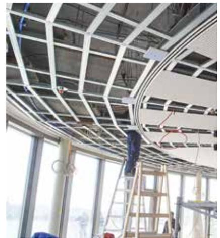
Gebogene Vierkantrohre und CD-Profile bilden das Grundgerüst der Kuppel. Mit Akustikputz beschichtete Akustikträgerplatten sorgen für angenehme Atmosphäre.
